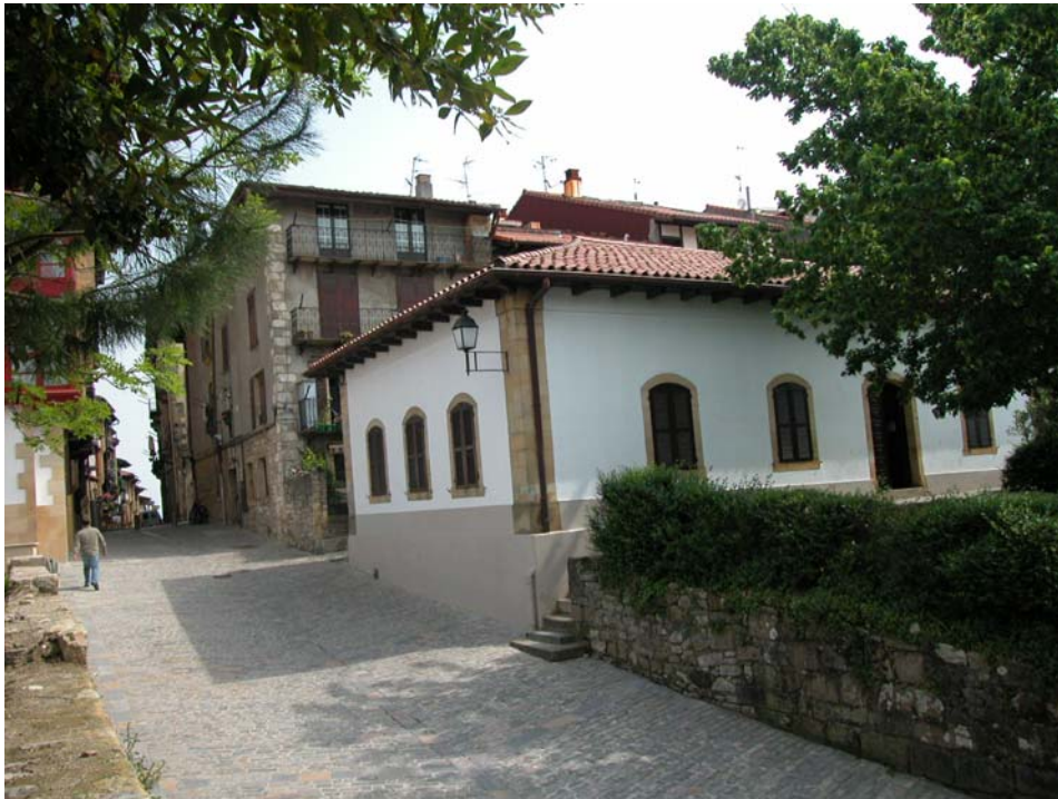
Vista de la parcela, con el jardín y edificio existentes, desde la calle Juan de Laborda
